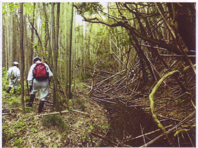
現況の荒れた道路と旧用水路跡
